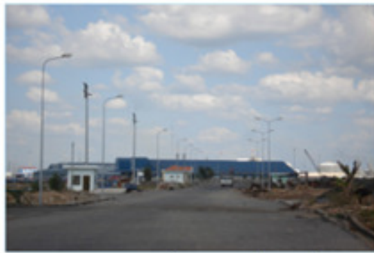
Hình ảnh: Thi công lắp đặt hệ thống chiếu sáng tại Nhà máy thép Phú Mỹ - KCN Phú Mỹ
