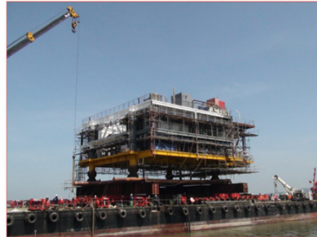
Hình ảnh: Thi công lắp đặt giàn khoan tại công trình Topside - RC Đối Mới
