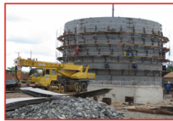
Hình ảnh: Chế tạo và lắp đặt bồn cứu hỏa
