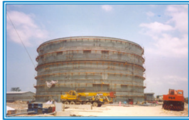
Hình ảnh: Chế tạo và lắp đặt bồn Condensate Dự án: Chế tạo và lắp đặt bồn Condensate - Nam Côn Sơn
