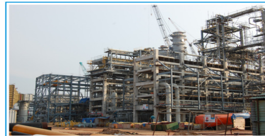
Chế tạo và lắp đặt hệ thống giá đỡ ống và thiết bị tại nhà máy lọc dầu Dung Quất
