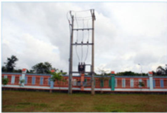
Hình ảnh: Thi công lắp đặt trạm điện tại Côn Đảo
