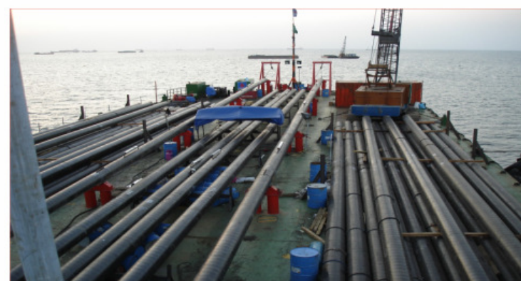
Hình ảnh: Thi công kéo thả 2 tuyến ống nhập 18" ngoài biển vào kho xăng dầu Cù Lao Tào
