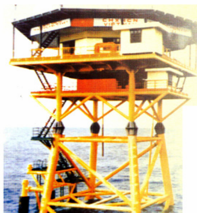
Hình ảnh: Bảo trì sửa chữa giàn DK của BQP
