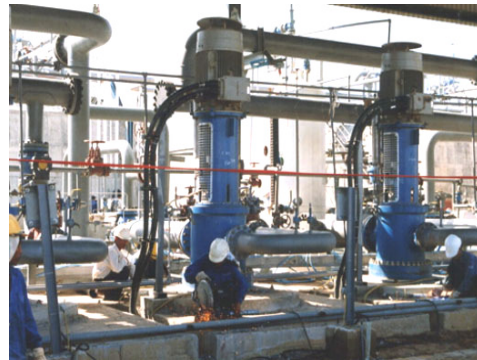
Lắp đặt hệ thống điện điều khiển và trạm bơm tại công trình đường ống kho chứa Thị Vải
