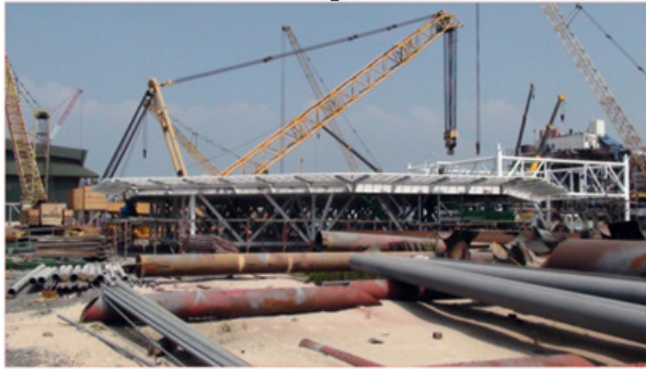
Hình ảnh: Thi công lắp đặt sàn bay tại công trình Topside - RC Đối Mới
