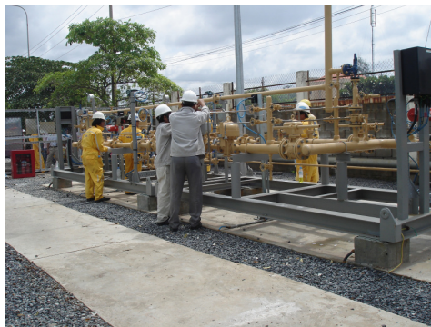
Kiểm tra hệ thống ống công nghệ trạm cấp khí thấp áp tại nhà máy gạch Hoàng Gia
