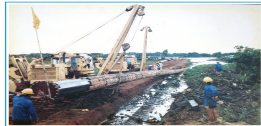
Lắp đặt tuyến ống Xi phông Tân Thuận II qua sông Sài Gòn
