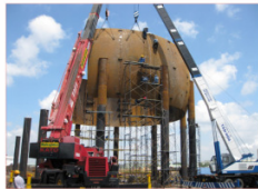
Hình ảnh: Chế tạo và lắp đặt bồn chứa LPG 2000 tấn
