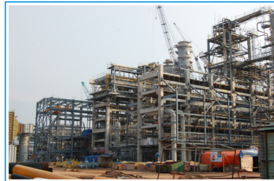
Chế tạo và lắp đặt hệ thống giá đỡ ống và thiết bị tại nhà máy lọc dầu Dung Quất
